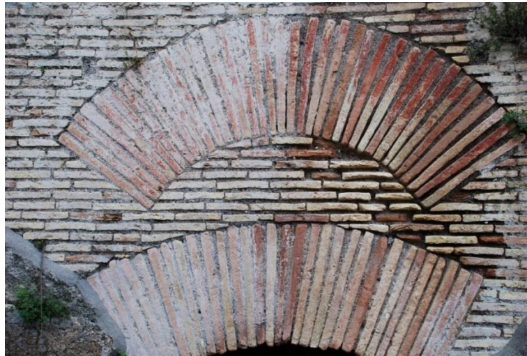
Opus latericium i en byggnadsvägg nära hamnen i Ostia, Italien (Ostia antica, regione IV, isolate IX). Fotografi: Camelia Boban, 2009. Wikipedia, CC BY-SA 3.0.
