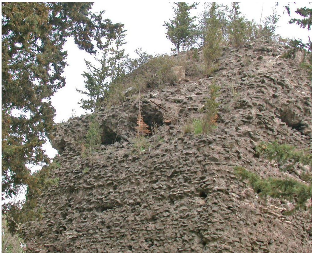
Rom, Via Appia Antica, en grav från antikens tid. Grundstruktur av opus caementicium . Wikipedia, Fotografi: MM, CCO.
