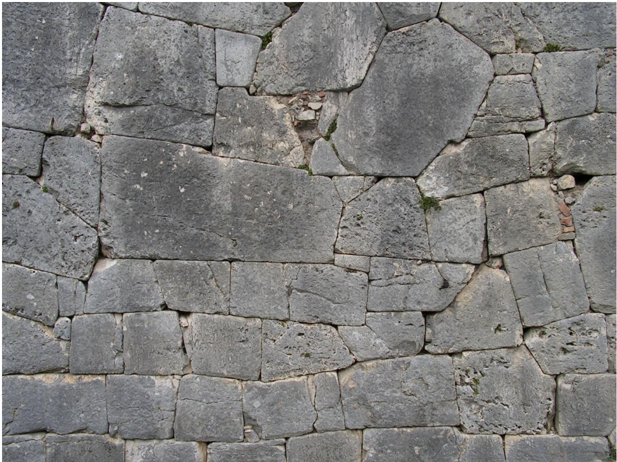
Amelia-muren i förromersk, polygonalstil i Umbrien i Italien (8:e till 7:e århundradet f.Kr.). Fotografi: Ameroe, 2008. Wikipedia CC BY-SA 3.0.
